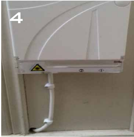
4 Innvendig koblingsboks ferdig satt opp på vegg.
