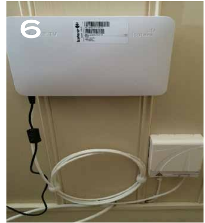
6 Her er kundeboks montert og koblet sammen med innvendig koblingsboks via abonnentkabel
