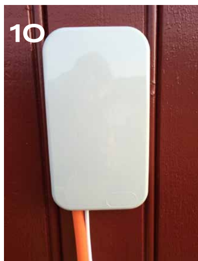
10 GP Nett monterer denne koblingsboksen på utsiden av huset ditt. Den kan males over om ønskelig.
