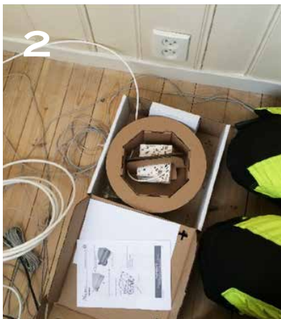
Her har vi strekt ut hele kabellengden og åpnet pappesken for å ta ut innvendig koblingsboks.
