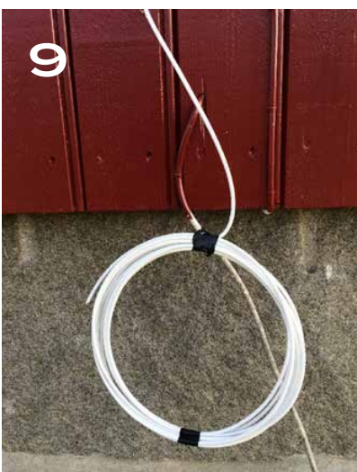
9 Resten av kabel henger du i kveil på utsiden av huset.
